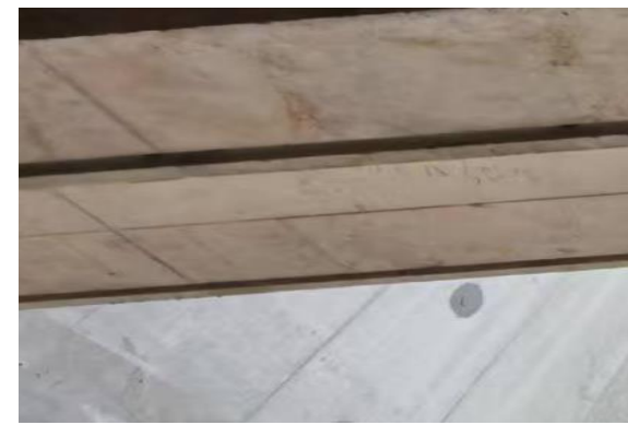
窗楣在主体施工阶段预留滴水凹槽
