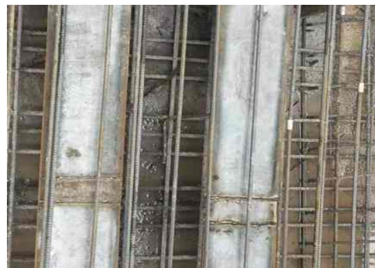
止水钢板满焊
