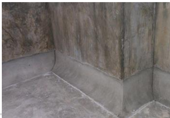
外墙防水基层R角处理
