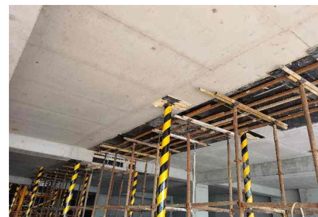
后浇带独立柱支撑
