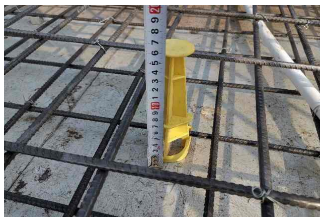
顶板使用板厚控制器，确保楼板厚度
