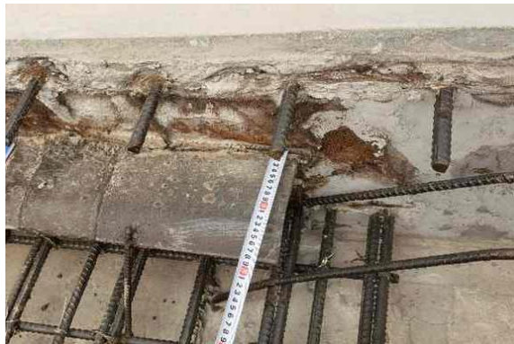
止水钢板满焊
