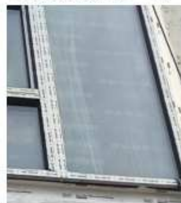
外侧粘贴防水透气膜
