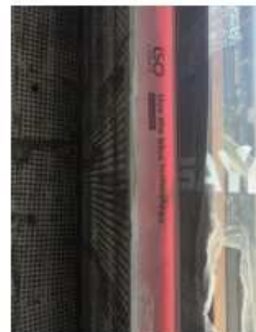
内侧粘贴防水隔汽膜
