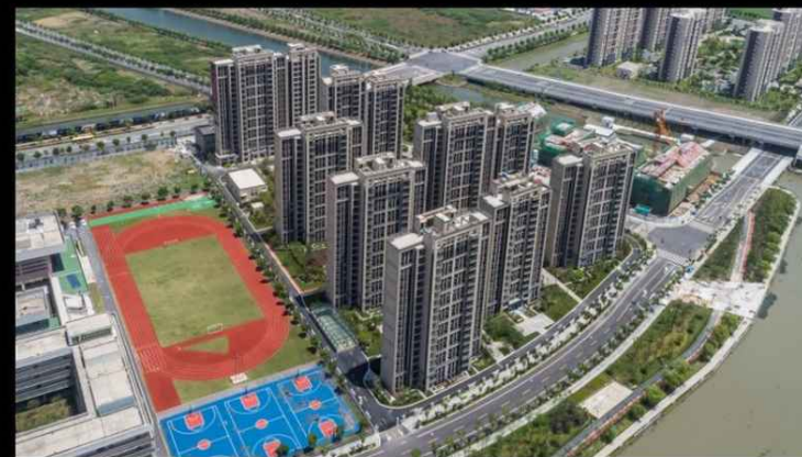
上海爱多邦住宅小区—装配率90%，全装修
