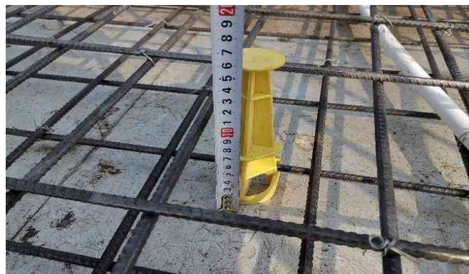
顶板使用板厚控制器,确保楼板厚度
