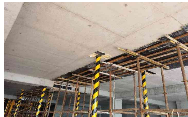
后浇带独立柱支撑
