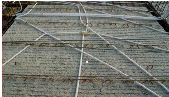
楼板采用成品桁架叠合板
