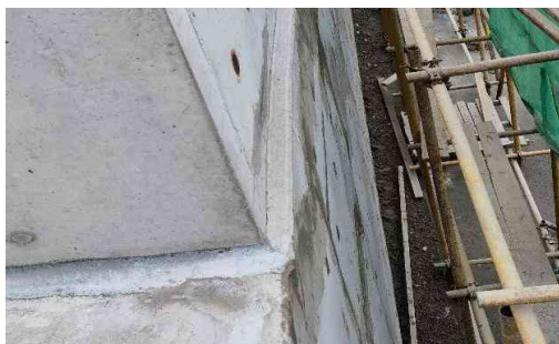
外墙防水基层R角处理
